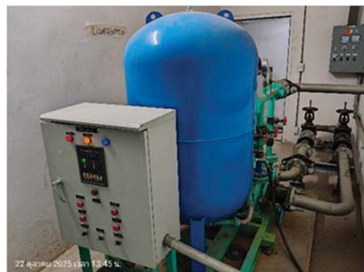
ถังเก็บน้ำ และ Booster Pump ชั้นตาดฟ้า
